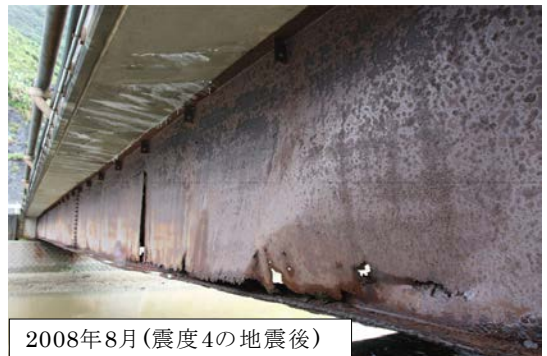
写真-4 腐食劣化の経年変化（山側のG3主桁外面）
