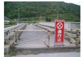
写真-3 全面通行止めの状況
