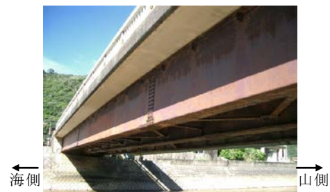
写真-1 腐食劣化の生じた橋の全景(2007年7月)
