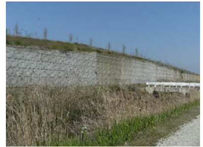
写真-2 補強土壁
