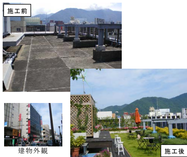
写真-1 業務ビルにおける屋上緑化施工前後の状況
