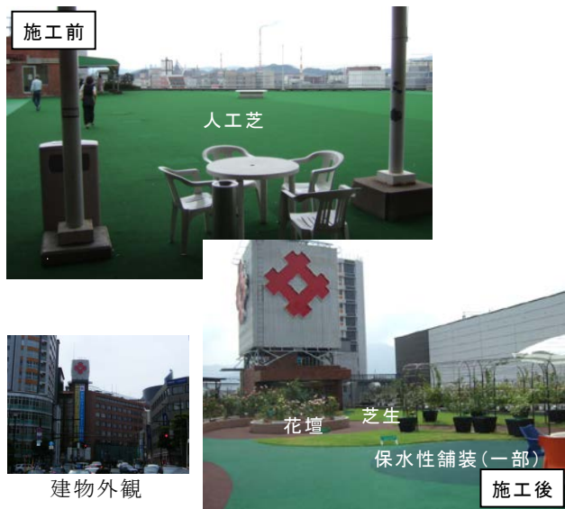
写真-3 大規模商業施設における屋上緑化施工前後の状況
