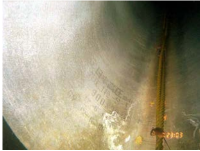
PC内にロープを設置したもの(豊富BP)
