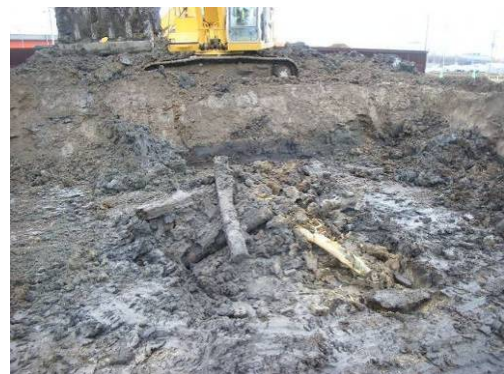
写真-3 掘削後に集められた廃棄物
