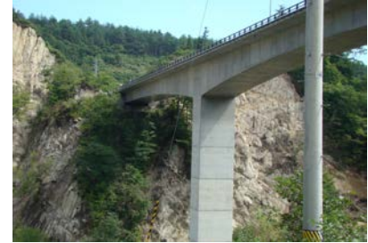
e) 地すべりによる直接基礎橋台の沈下
