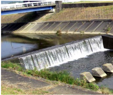
図-4 本研究において調査対象とした構造物 (構造物6)
