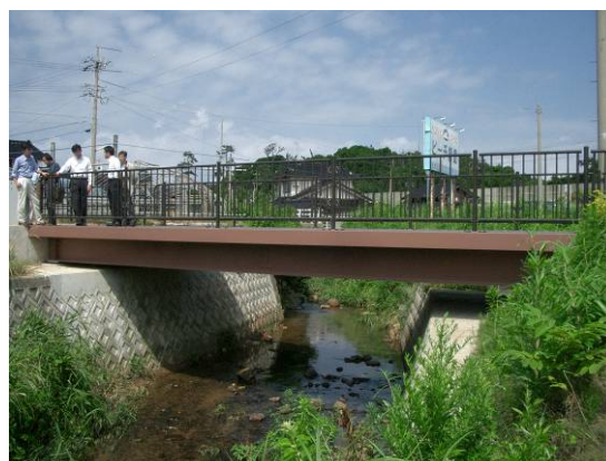
写真-3 FRP桁歩道橋の例（石川県）
