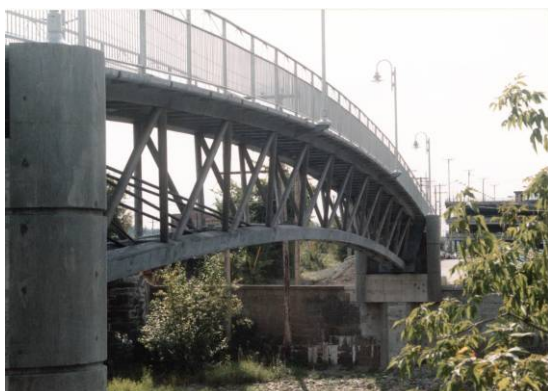
写真-2 超高強度繊維補強コンクリートを用いた歩道橋
