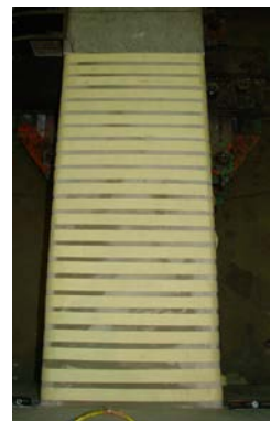
(c) 修復完了
