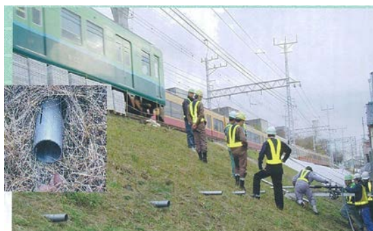
写真-2 既設盛土への水平排水孔の打設
