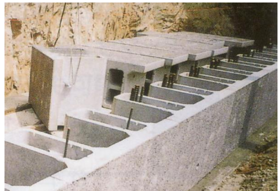
写真-3 多分割型のL型コンクリート擁壁
