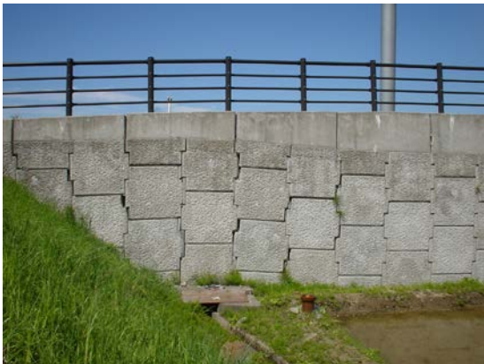
写真-4 補強土擁壁のパネルの変状（地震時）
