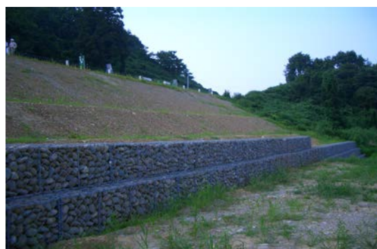
写真-1 のり尻部への蛇かごの設置
