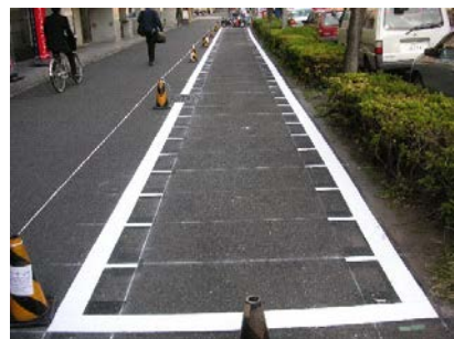
写真-6 駐輪場設置状況
