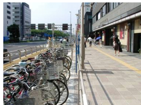
写真-11 整備後の歩道部の状況
