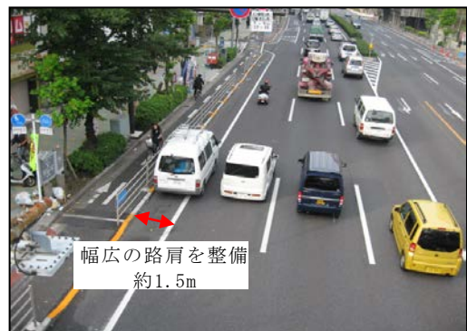
図-7 路肩部の整備
