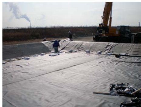
写真-2 充填ヤードの造成状況
