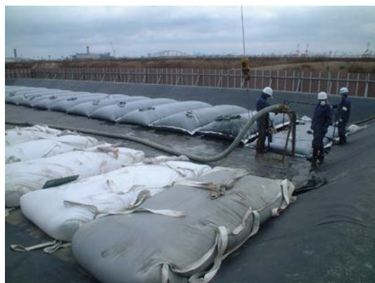
写真-6 施工性の確認試験の状況
