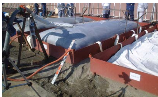
写真-3 鋼製の仮設台での充填状況
