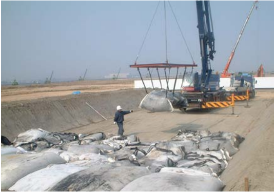
写真-4 袋体の運搬状況
