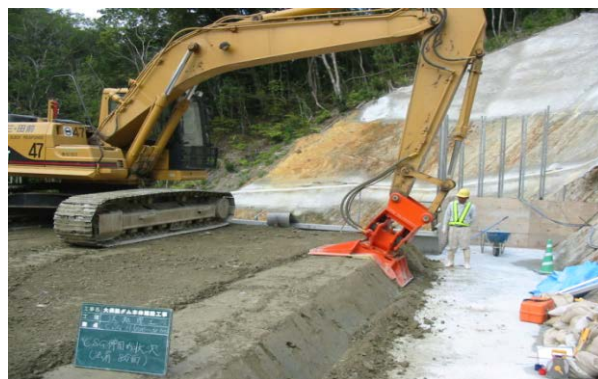
写真-1 CSG法肩締め機
