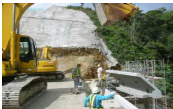
写真-2 上流面型枠のプレキャスト化
