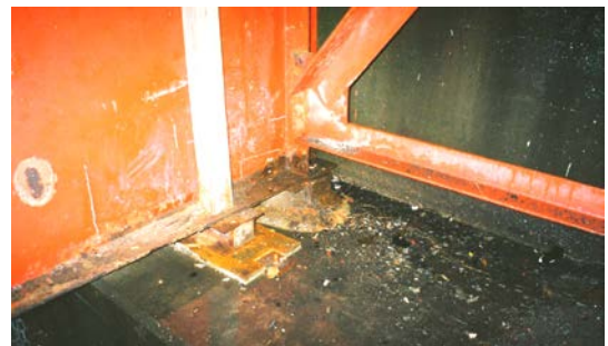
写真-2 橋台上の土砂堆積と鋼桁端部の腐食
