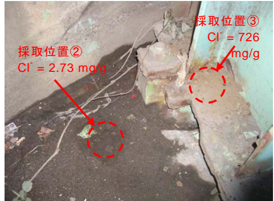
写真-5 橋台及び鋼桁上の土砂(12月に採取)
