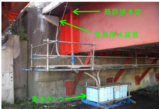
写真-4 排水調査の状況
