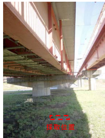
写真-7 排水管直下の試料採取位置
