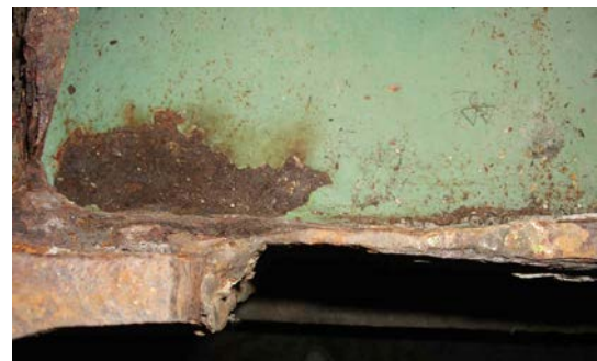
写真-6 鋼桁下フランジの腐食による著しい断面欠損
