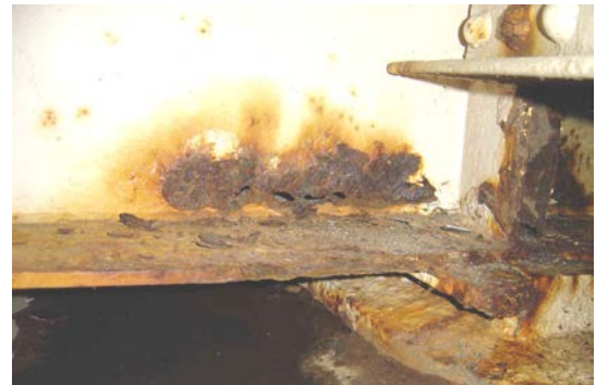
写真-3 鋼桁端部の著しい腐食の一例
