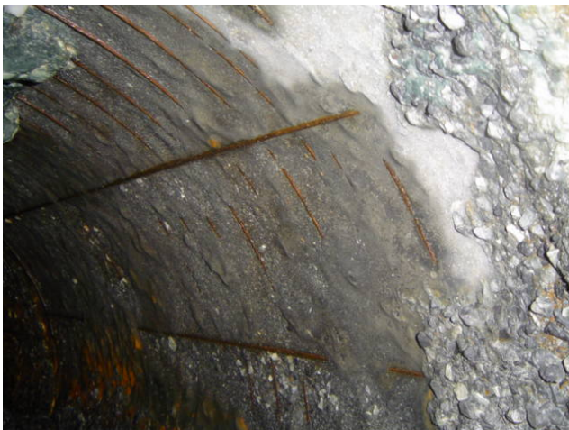
写真-1 下水管内のコンクリート腐食状況 管の上半分の鉄筋が露出。サビ腐食が進行。
