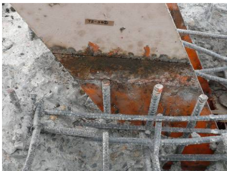
写真-3(1) 埋設部材の外観（床版上面）
