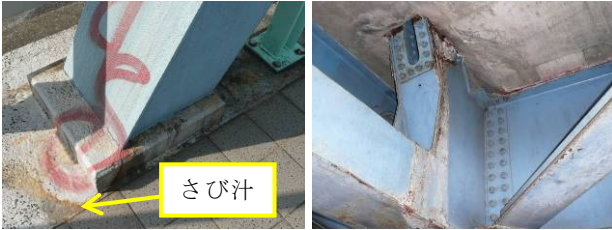
写真-12 埋設部材状況
