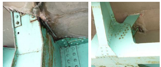
端斜材（箱形断面）
