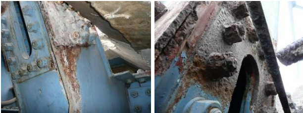
写真-13 埋設部腐食状況
