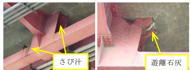
写真-2 床版下面からの外観調査結果
