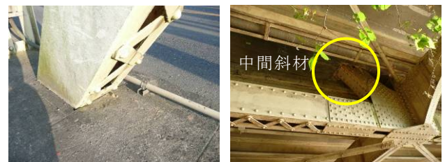
写真-10(2) 埋設部状況 (中間斜材)
