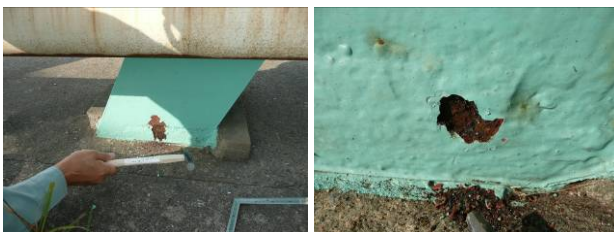
写真-8 塗膜下の腐食
