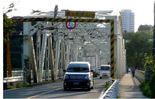
写真-9 水府橋外観
