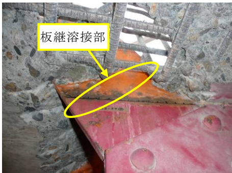
写真-3(2) 埋設部材の外観（床版下面）
