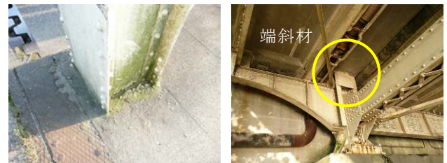
写真-10(1) 埋設部状況 (端斜材)
