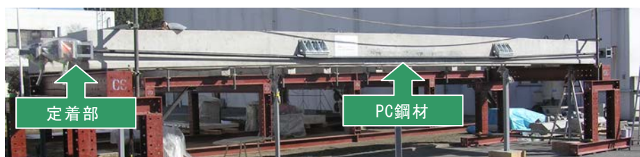
図-6 断面修復・外ケーブル工法適用後の供試体
