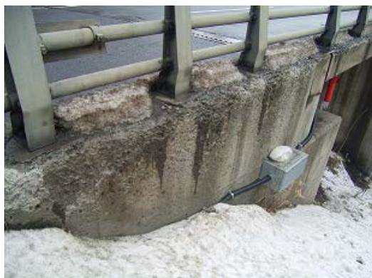
写真-1 橋梁地覆コンクリートの複合劣化
