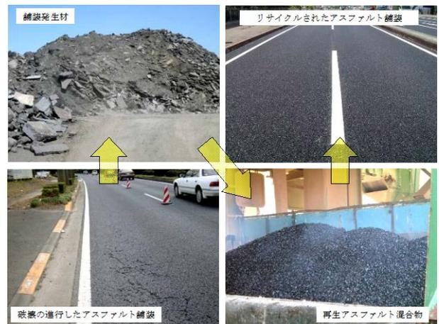
図-2 舗装発生材の再生フロー
