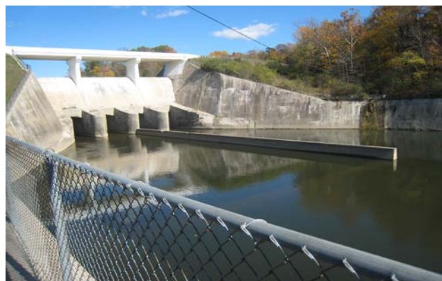
写真-1 TAYLORSVILLE DAM 洪水吐き、減勢工
