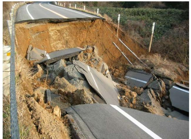
図-3 道路盛土の崩壊事例（能登有料道路）
