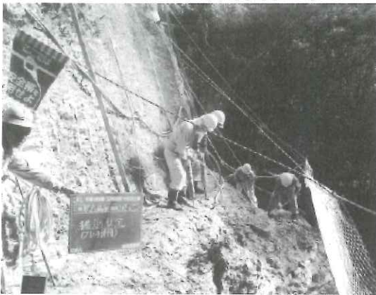
写真-1 作業状況写真(岩石除去工)
