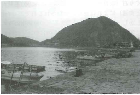
写真-1 三角西港護岸 (熊本県宇城市三角町) オランダ人技師ムルドルの指導により明治初期に建設
