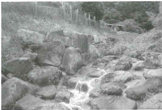
写真-2 多自然型工法への石材の使用例 (茨城県つくば市) 河川改修に際し、周辺環境との調和と材料の有効利用を図る目的で、工事に伴う発生材 (筑波石) を用いて石積み護岸を施工
