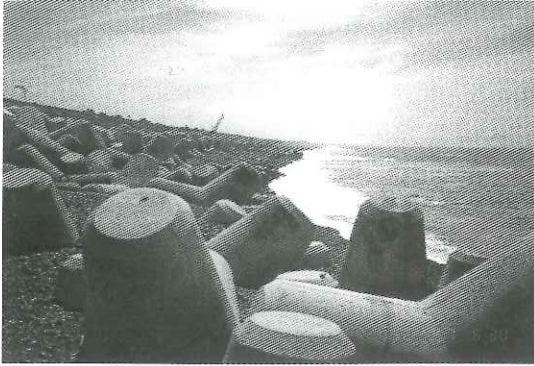
写真-3 1997年6月の昭和放水路東側の状況 (西から)
