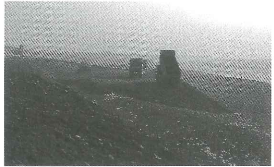
写真-1 静岡県富士海岸の養浜工事風景
