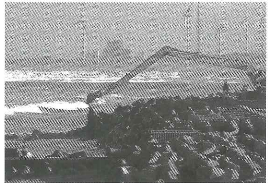
写真-2 茨城県神向寺海岸の養浜工事風景
