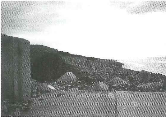
写真-4 2000年3月の昭和放水路東側の状況 (西から)
