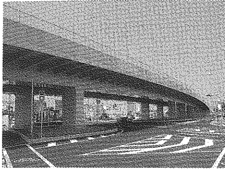
写真-1 交差点立体交差の急速施工技術
