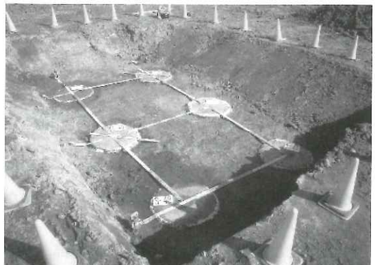
写真-2 施工後の様子
