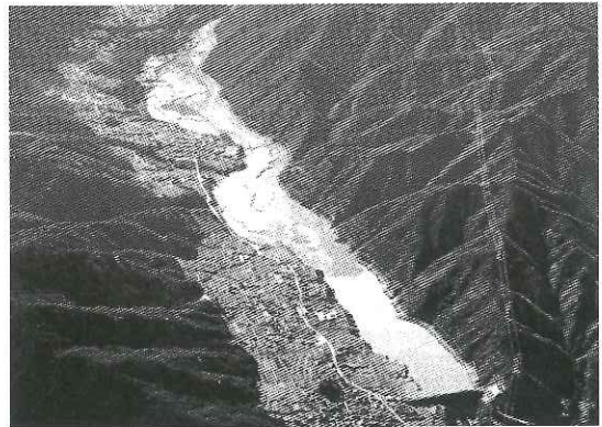
写真-1 堆砂が進行したダム
