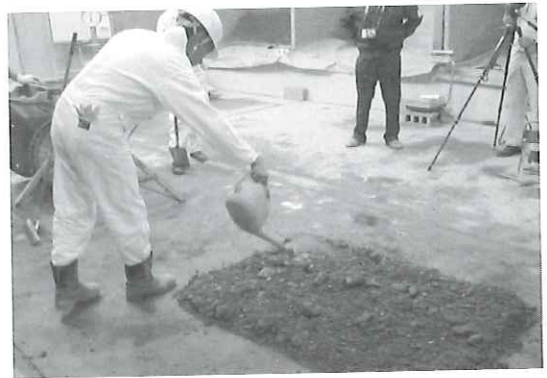
写真-4 2次混合水散布状況
