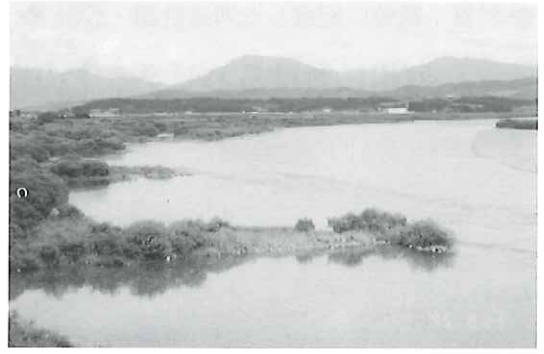
写真-3 最上川 13km 付近の根固め水制の状況
