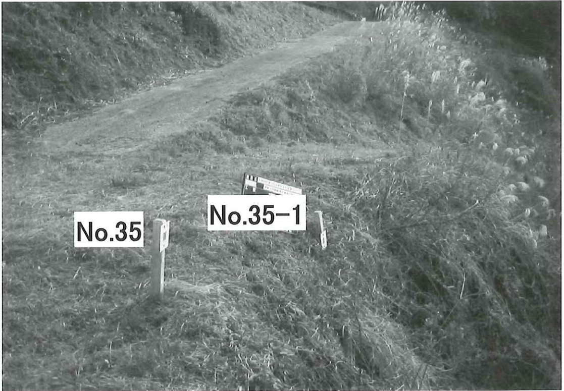
写真-3 計測点 No.35 及び No.35-1 の設置状況
