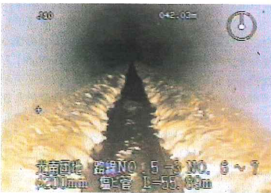
写真-2 設置後 (平成 13 年 6 月)
