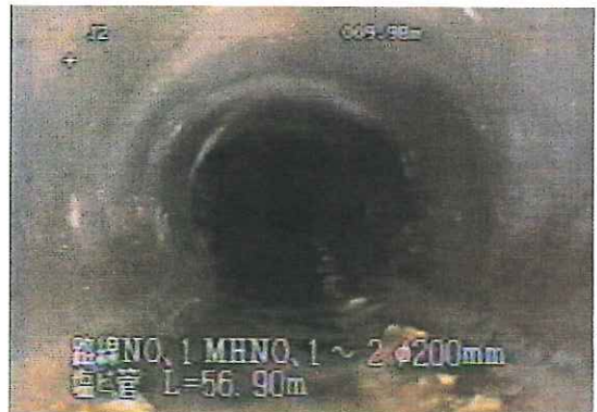
写真-3 設置前 (平成 11 年 7 月)
