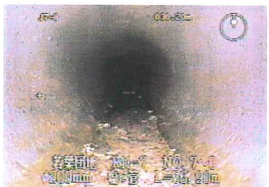
写真-4 設置後 (平成 12 年 8 月)
