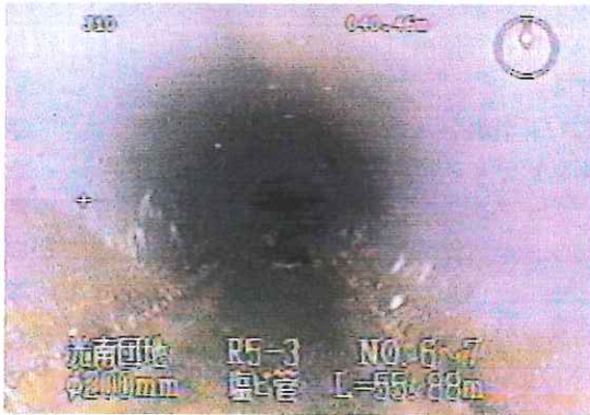
写真-1 設置前 (平成 12 年 9 月)
