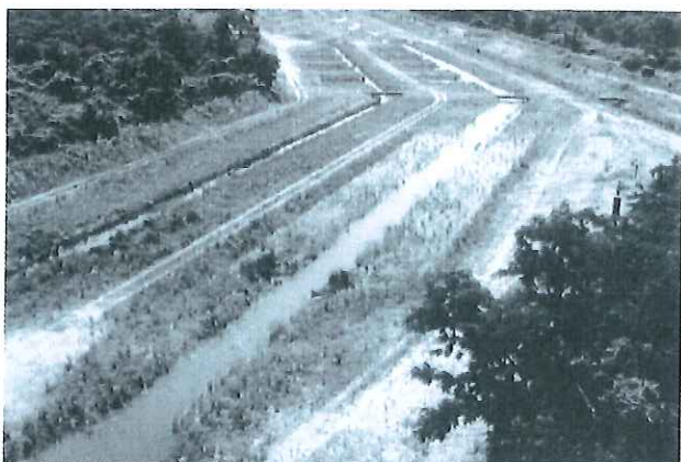
写真-2 実験河川下流部
