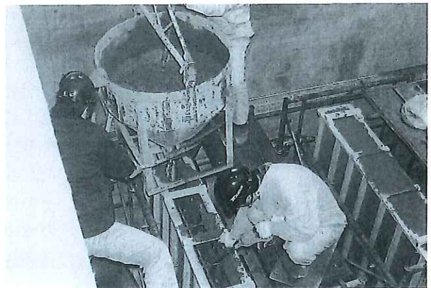
写真-1 打設状況
