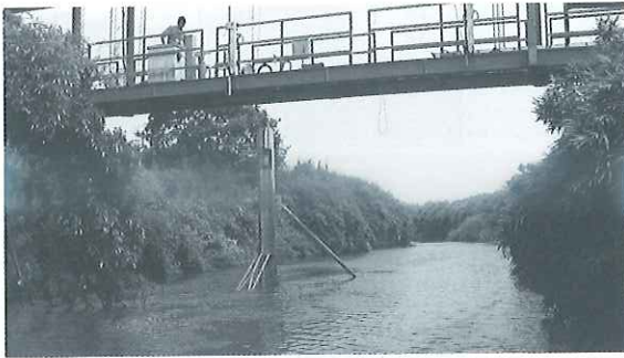
写真-1 瀬沼洪水観測施設 (28.1km)
