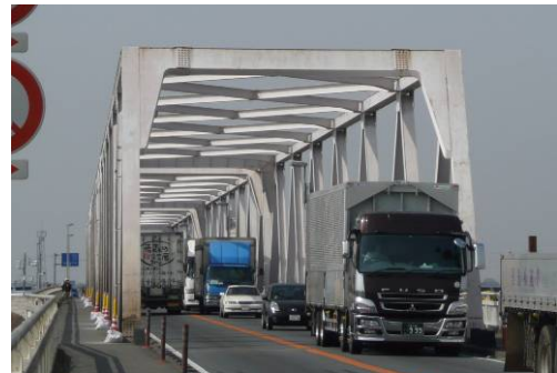
写真-1 三国橋外観
