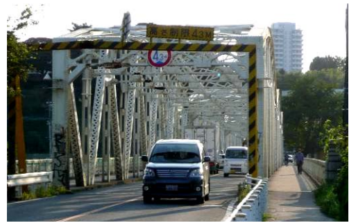
写真-9 水府橋外観
