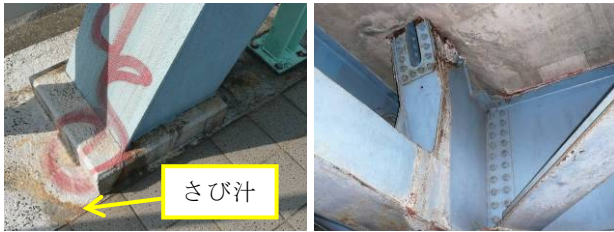
写真-12 埋設部材状況
