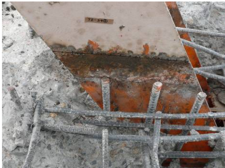
写真-3(1) 埋設部材の外観（床版上面）
