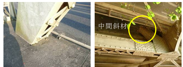
写真-10(2) 埋設部状況 (中間斜材)
