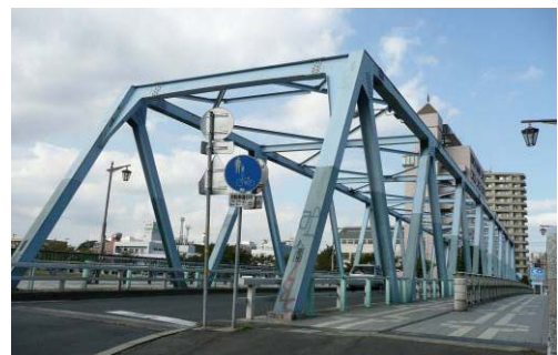
写真-11 美都里橋外観
