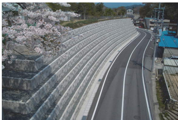
写真-2 切土拡幅の施工例
