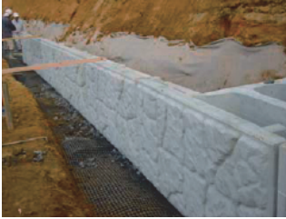
写真-3 最下段の箱体据付 図-8 各段の箱体設置
