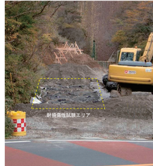
写真-3 耐損傷性試験
