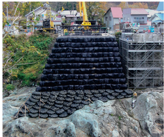
写真-7 耐候性大型土のうとの組合せ事例（工所用仮設構台）
