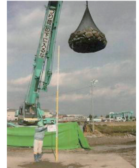
写真-4 落下・吊上げ性能試験
