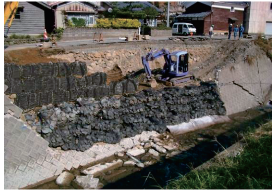
(a) 基礎地盤に適用した事例
