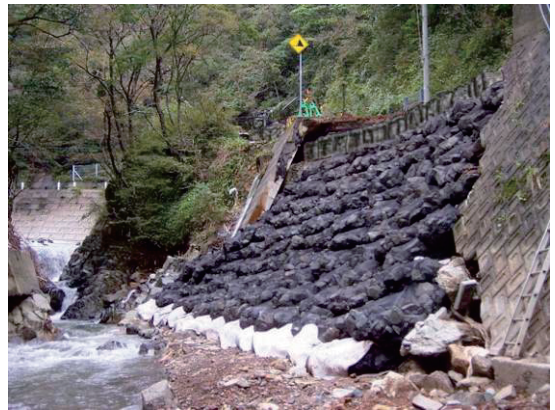
(b) のり面対策に適用した事例
