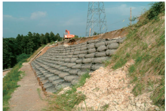
写真-5 適用事例（土留め構造物）
