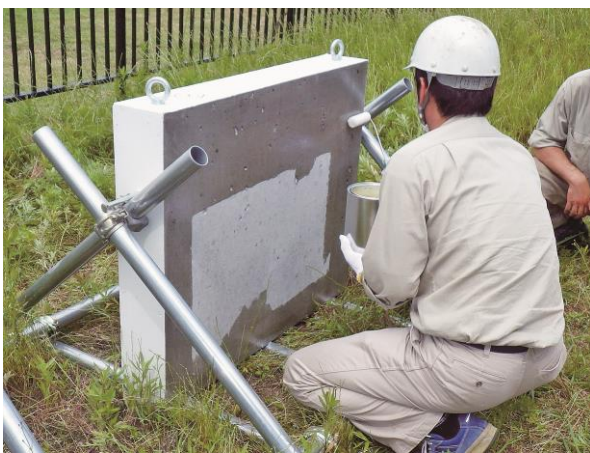
写真-2 浸透材塗布状況
