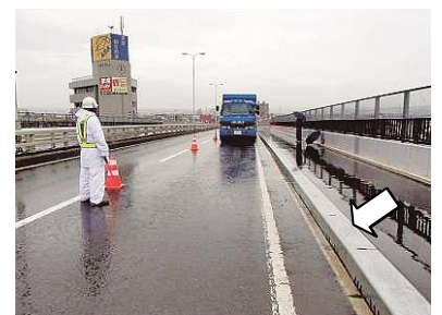
写真-7 鋼製排水溝
