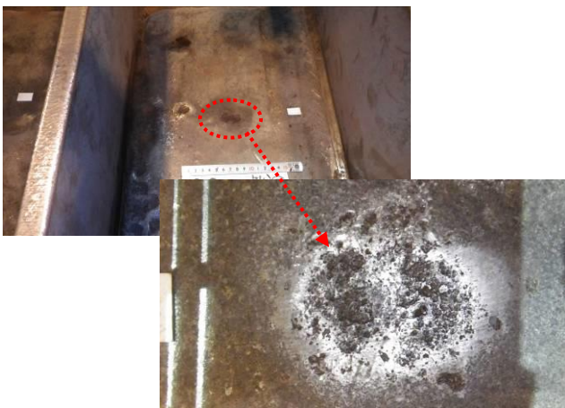
写真-10 2種ケレンの仕上がり状態 (2回目)
