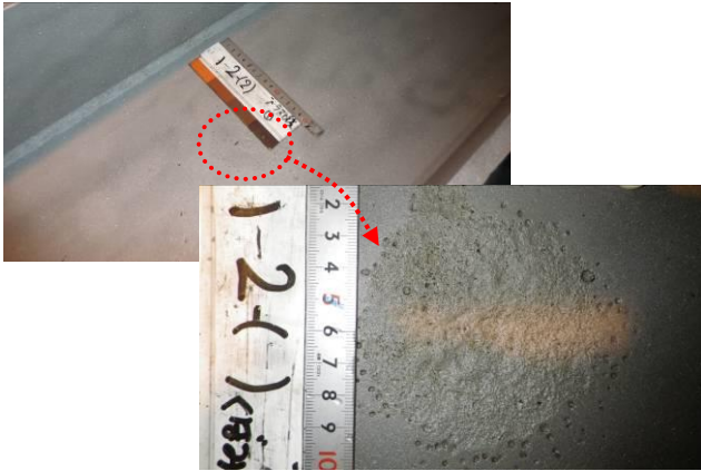
写真-9 1種ケレンの仕上がり状態 (1回目)
