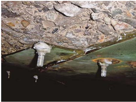
写真-3 床版の下面の状況
