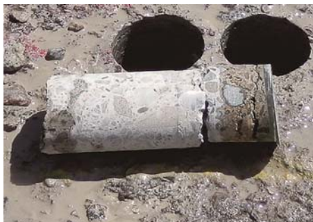
写真-5 床版のコア抜き（右側が床版下面）
