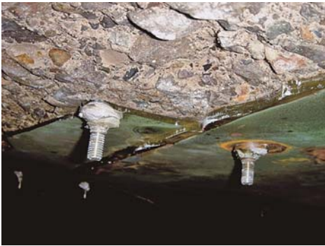
写真-3 床版の下面の状況
