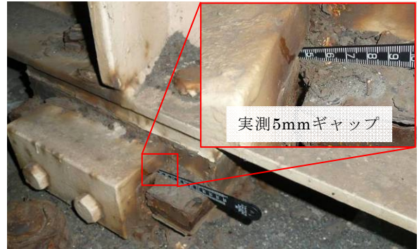
写真-3 実測状況
