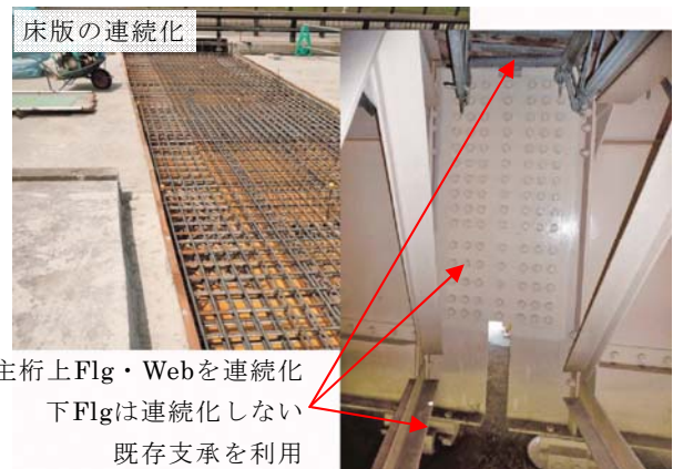
写真-4 連続桁化の施工
