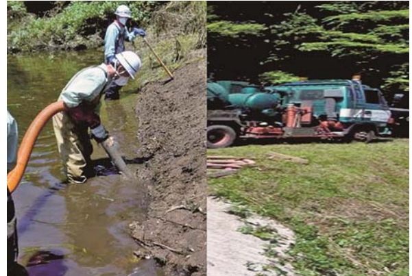
写真-1 集泥・吸引状況とバキューム車
