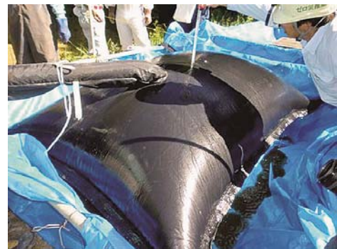
写真-2 底泥の袋への充填状況
