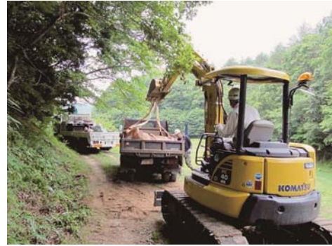
図-7 脱水後の袋の吊り上げ・運搬状況
