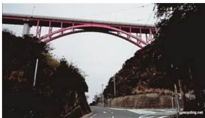
写真-1 堀切大橋全景
