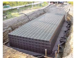
写真-3 施工状況
