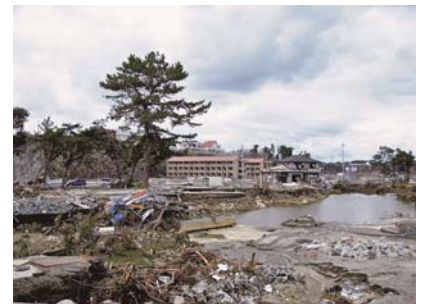
図-9 破堤時に形成された大きな池
