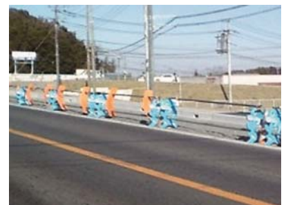
写真-3 工事中バリケードの設置例
