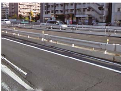
写真-5 連続基礎ブロックタイプ仮設柵の設置例
