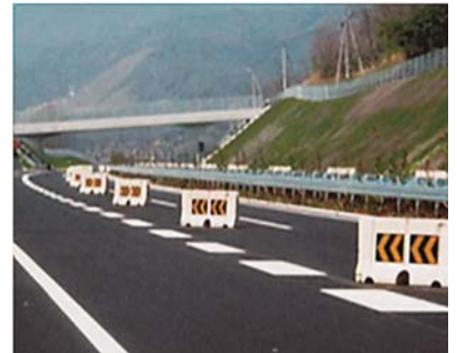
写真-7 壁ブロックの単独設置例 2)
