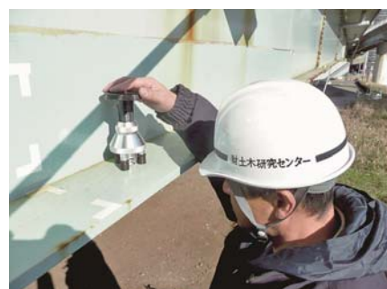
写真-4 アドヒージョンテスターによる測定状況
