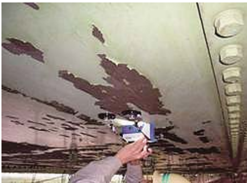
写真-3 塗膜断面調査
