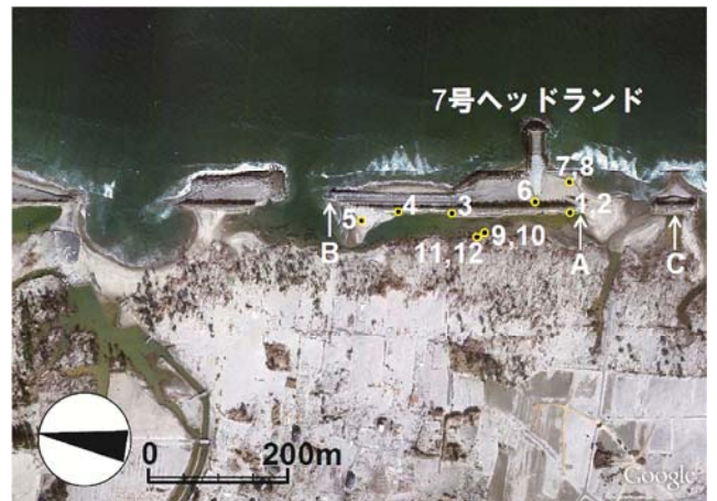
図-3 宮城県山元海岸の調査区域 (2011年4月6日撮影) と写真撮影地点
